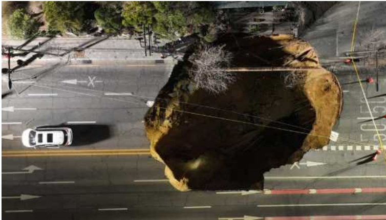
<그림 7. 명일동 대형 싱크홀> 출처: 한겨레
